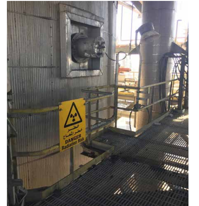
نموذج من أحد الممارسات الإشعاعية الصناعية (أجهزة القياس النووي أثناء التفتيش)
