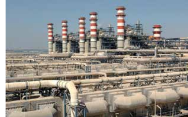
محطة تحلية مياه البحر
