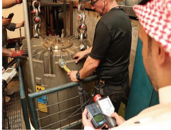
المصادر المشعة لوحدة التشعيع بعد التفكيك ومعاينتها وتحميلها بالحاوية المخصصة للنقل.
